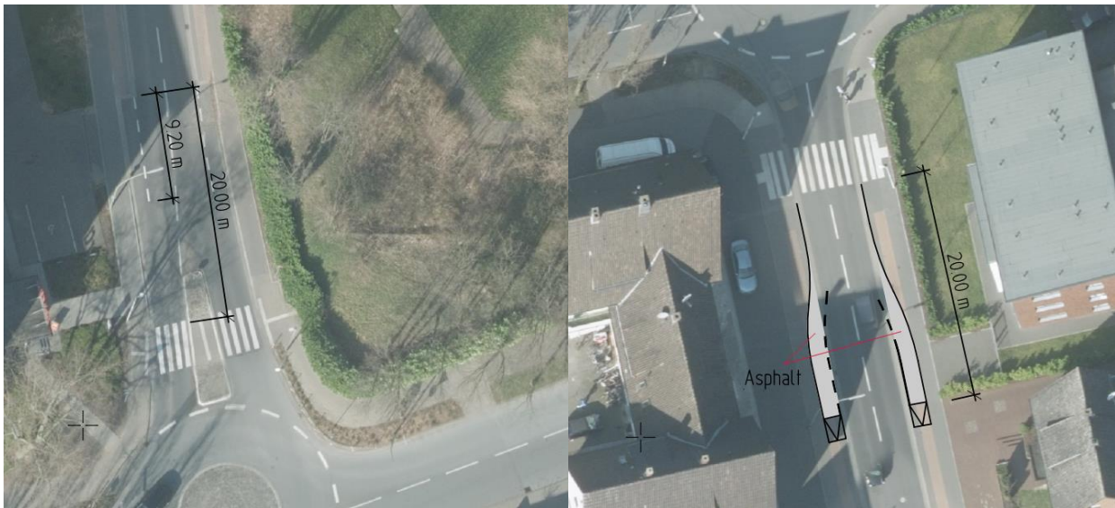
Abbildung 67: nördliche Zufahrt (links), südliche Zufahrt (rechts)
